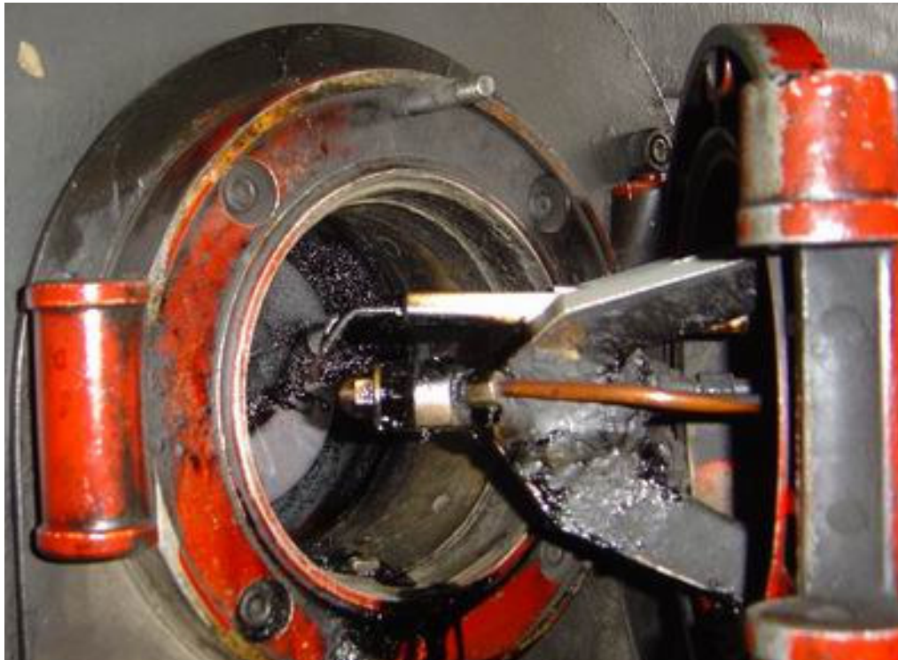
รูปที่ 4.1 หัวฉีดใช้งานมานานกว่า 3 ปี ทำให้มีปัญหาการฉีดน้ำมัน
