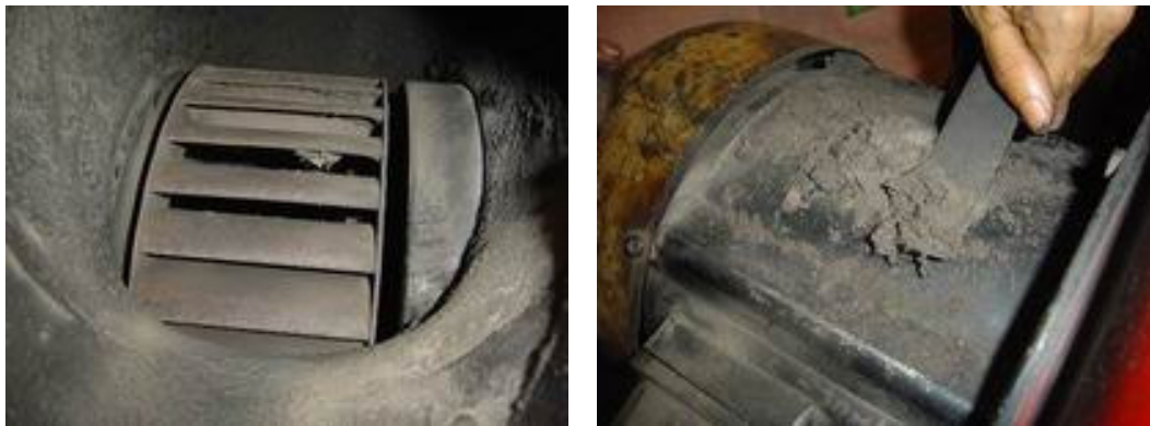
รูปที่ 4.8 ใบพัดของพัดลมดูดอากาศสกปรก
