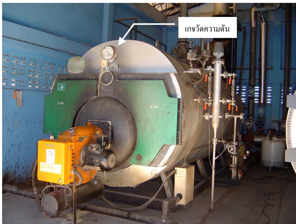
รูปที่ 3.11 แสดงเกจวัดความดันไอน้ำ
