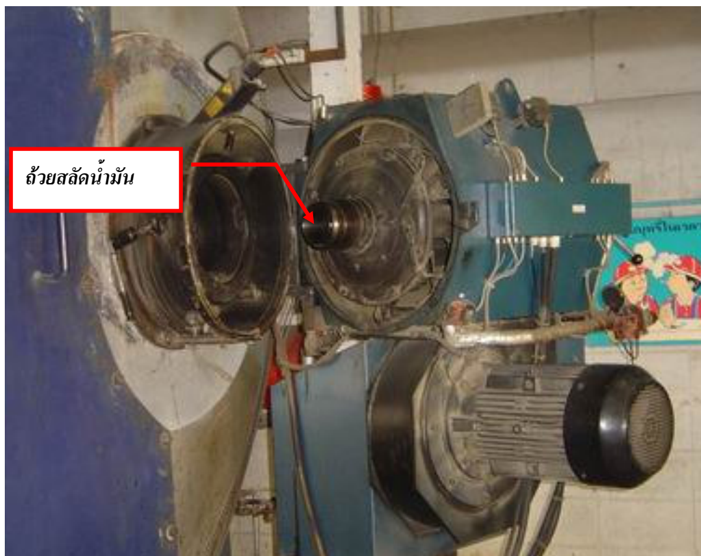
รูปที่ 4.26 หัวเผาชนิดพ่นฝอยด้วยถั่วหมุนสลัดน้ำมัน ควบคุมแบบต่อเนื่อง (Modulating)
