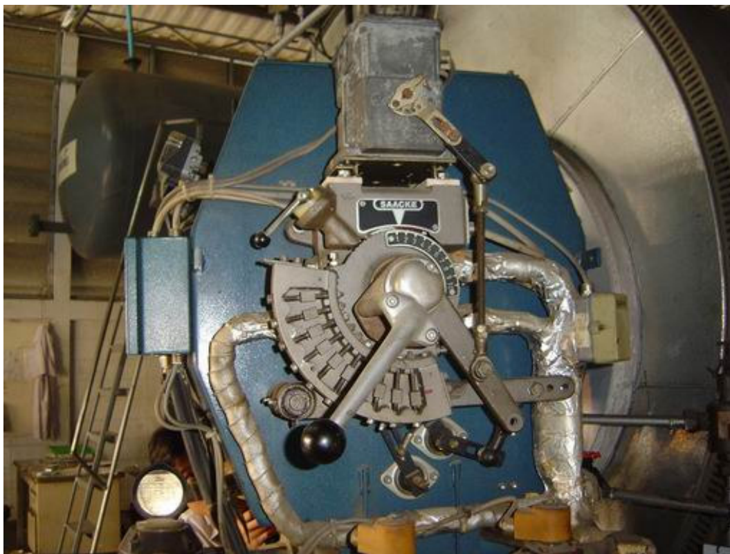
รูปที่ 4.27 ชุดควบคุมน้ำมันและอากาศ
