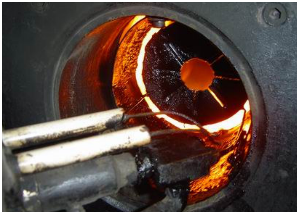
รูปที่ 4.2 มีปัญหาการฉีดน้ำมันทำให้เกิดการกองของน้ำมันในห้องเผาไหม้
