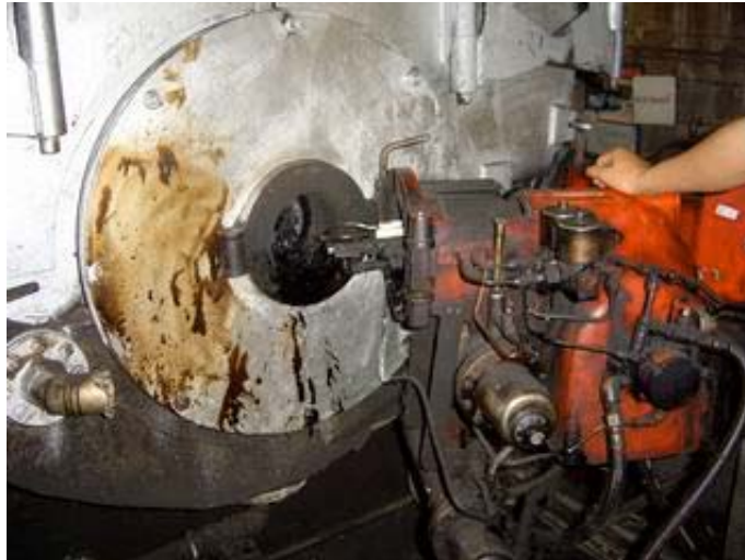
รูปที่ 6.2 หัวเผาของหม้อไอน้ำ
