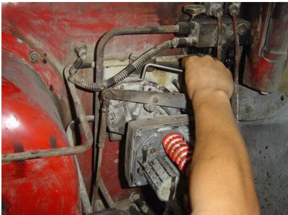
รูปที่ 4.20 แสดงการใช้ประแจหกเหลี่ยมปรับ สกรูปรับแต่ง Spring band
